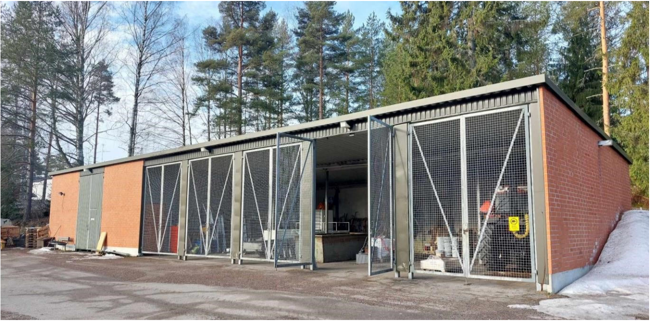
Kuva 8. Teknisen varikon varastorakennus.
