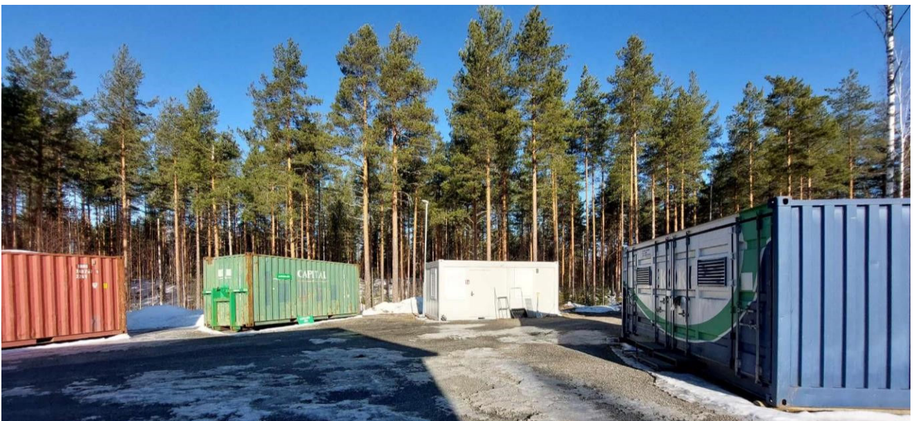
Kuva 22. Kunnan varikko/Jäteasema, Kuortintie 138.
