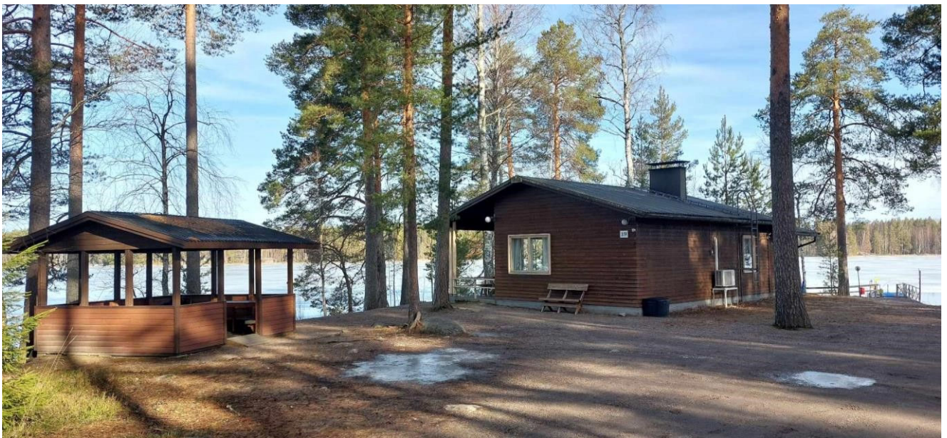
Kuva 26. Veljesniemen saunarakennus ja grillikatos.
